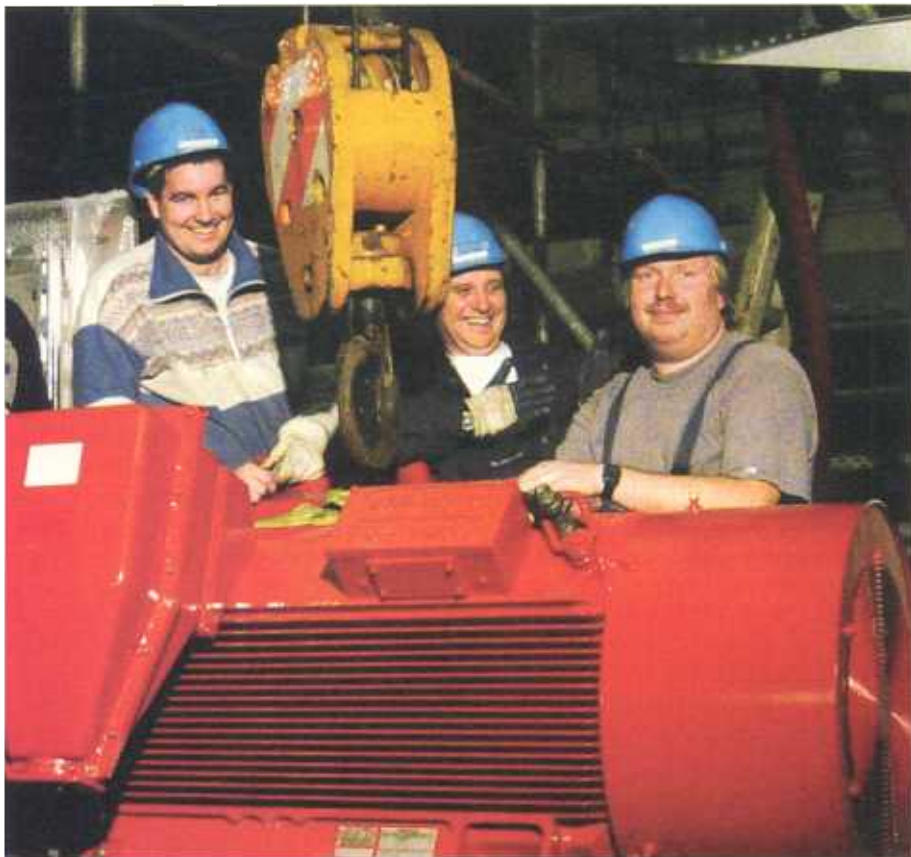
Von links nach rechts: Volker Menzel, Manfred Matysik, Roland Cobel mit einer Netzwälzpumpe für die Kaltwasserversorgung von Kraftwerke
